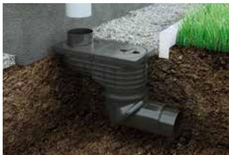
1. Posizionare il pozzetto per lo scarico dell'acqua piovana
